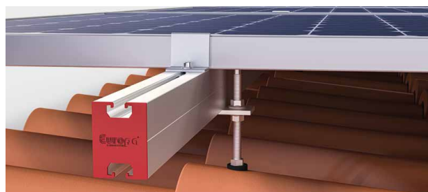
Τοποθέτηση με νιζοστρίφωνο
